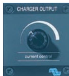
Le courant de quai étant parfois insuffisant, le potentiomètre sur ce panneau permet de limiter la puissance absorbée par le chargeur et ainsi d'éviter de faire disjoncter la borne d'alimentation du quai.
